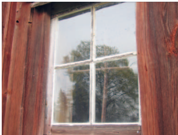
Eksempel på en bygningsdel med tilstandsgrad 1, her illustrert med et vindu med noe løst kitt og med maling som er slitt bort.
