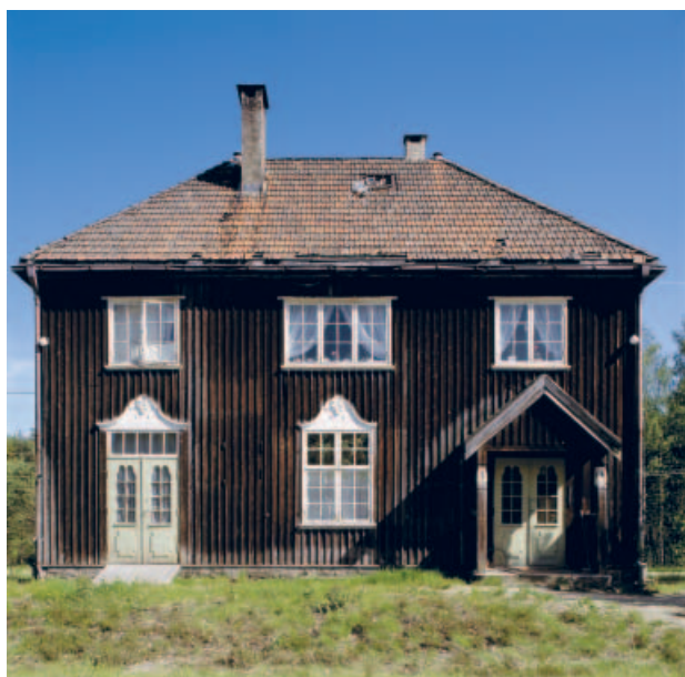
Jernbanestasjonen på Sandå i Åmli kommune. Foto: Riksantikvaren
