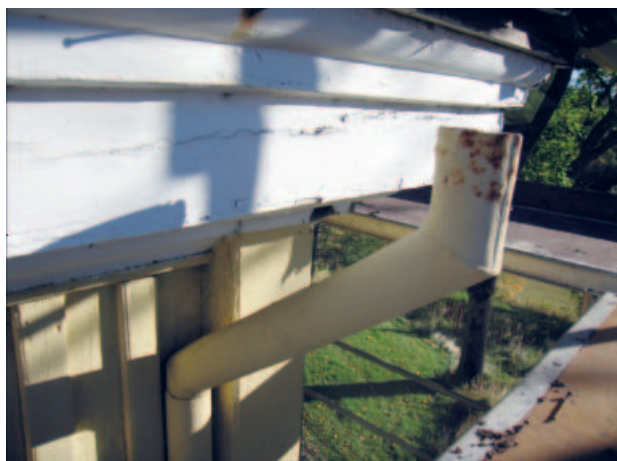
Eksempel på bygningsdel med tilstandsgrad 2, her illustrert med enkelte defekte deler i renner eller nedløp.
