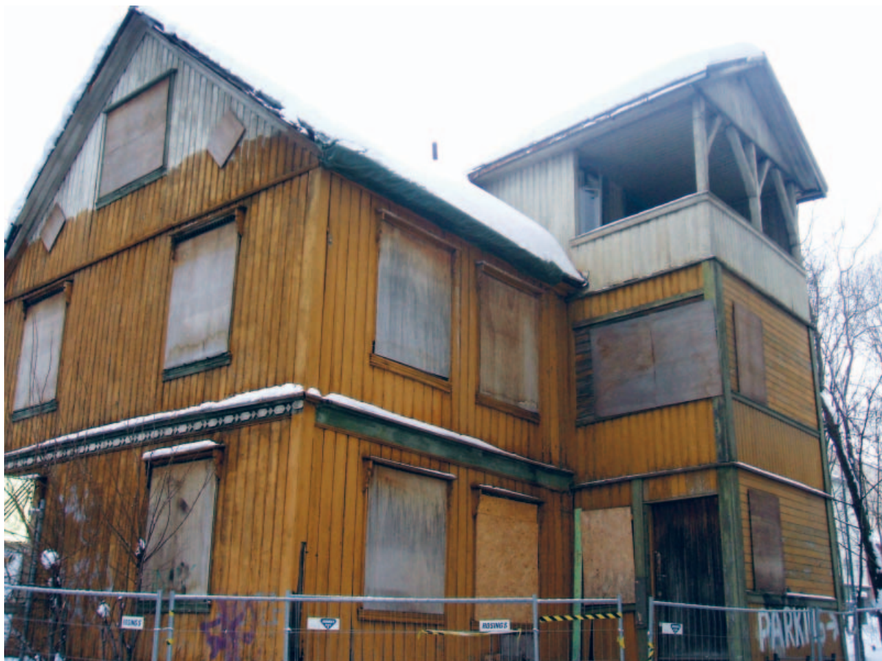
Eksempel på en verneverdig bygning, regulert til spesialområde bevaring, som forfaller.
