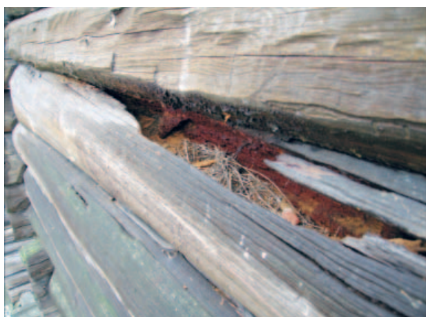
Eksempel på bygningsdel med tilstandsgrad 3, her illustrert med gjennomgående råteskader i store deler av en laftevegg.
