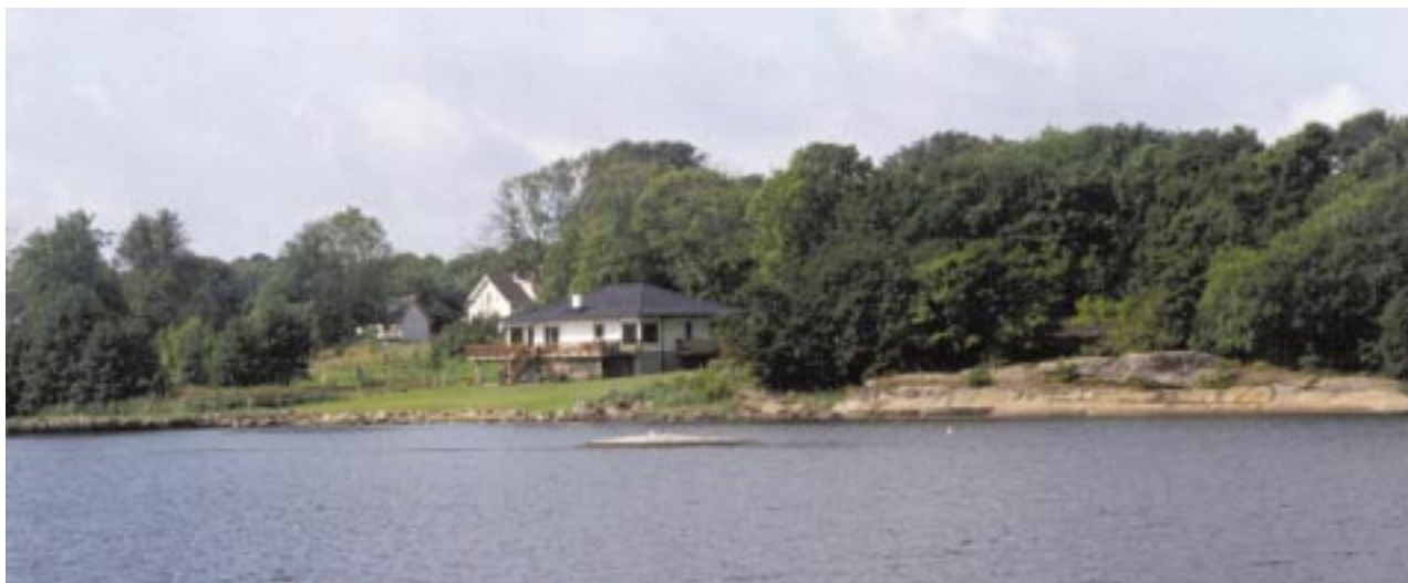
Bilde 3 viser en helårsbolig bygd etter dispensasjon
