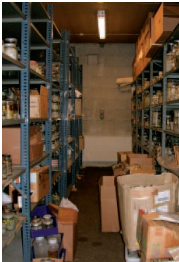
Brannsikring: Våtmagasinet for insekter ved Naturhistorisk museum i Oslo oppbevares i en garasje. Det oppbevares ca. 2200 liter sprit i dette rommet, som har mangelfull ventilasjon og isolering. Dette representerer en stor brann- og eksplosjonsfare.
