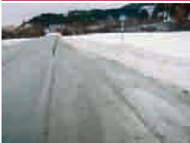
Figur 3 Is dekkjer kantlinja etter ein lengre periode utan nedbør, E14 8. januar kl. 13.08 (karakter 3,5)
