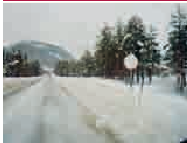
Figur 4 Våt is (hålkføre) utan strøtiltak, friksjonskoeffisient 0,10–0,15. RV705 8. januar kl. 11.45 (karakter 1,0)
