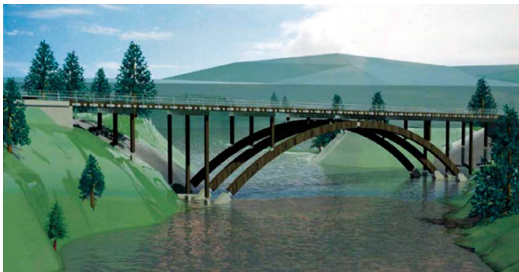
Bygging av ny bru over Åsta elv skal fjerne en flaskehals på riksvei 3.
