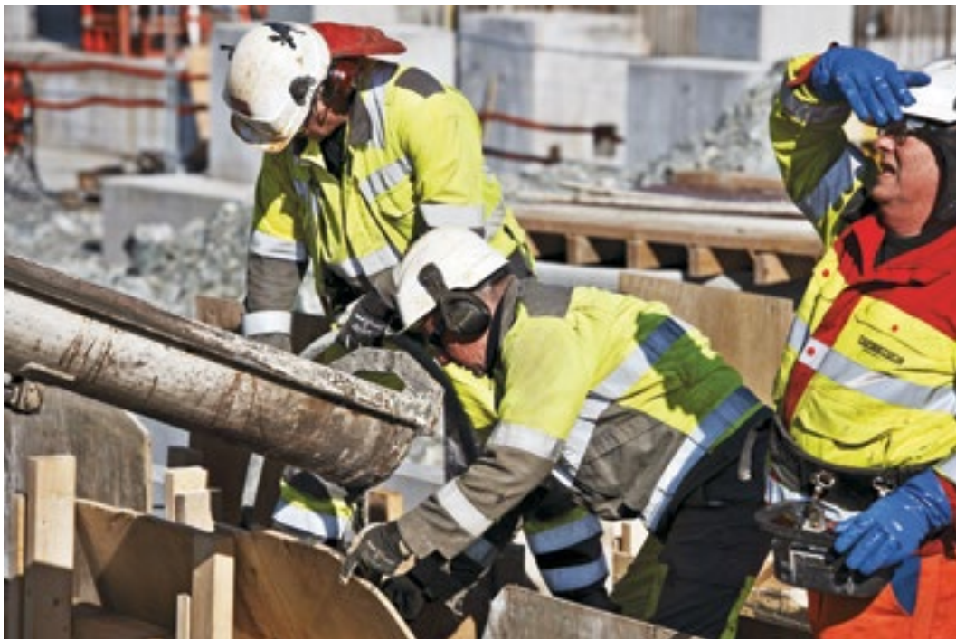
Fra byggingen av Teknologisenteret på Mongstad.
