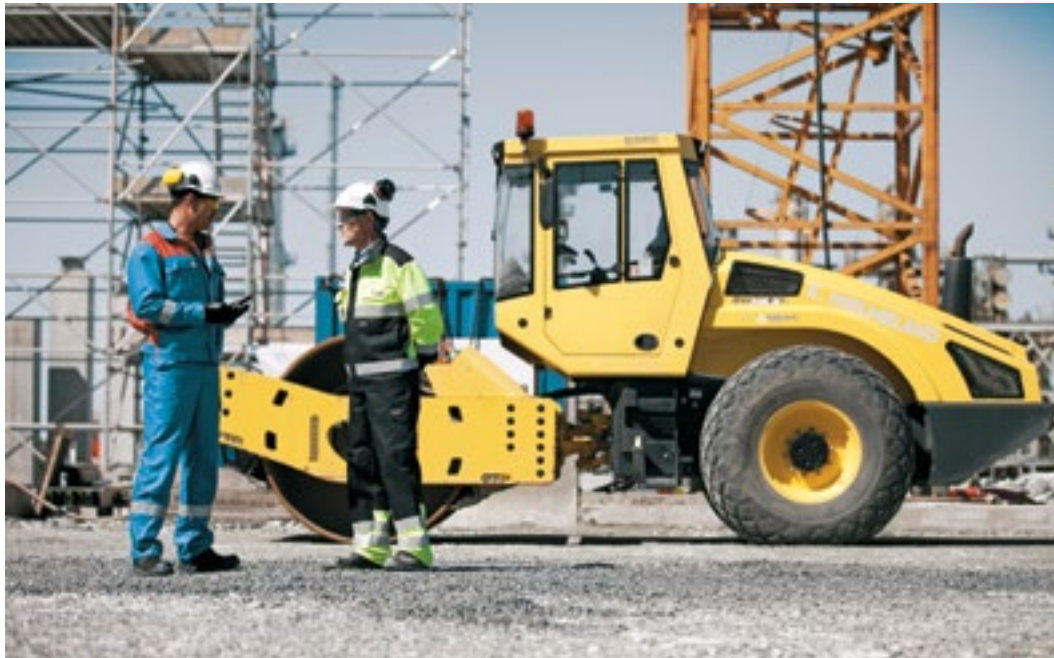
Fra byggingen av Teknologisenteret på Mongstad.
