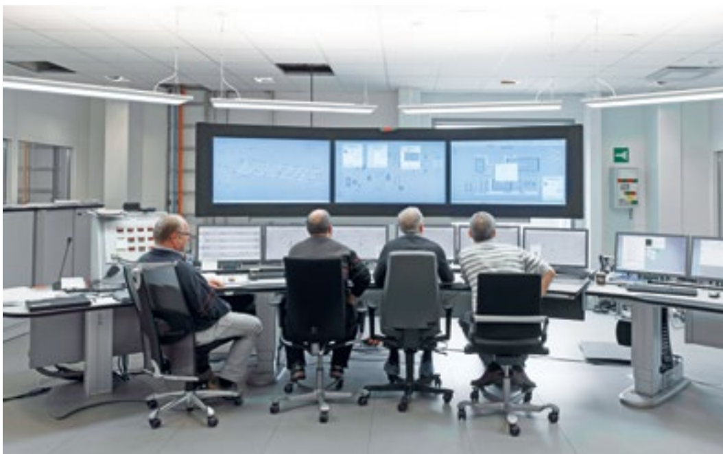
Kontrollrom i administrasjonsbygget – Teknologisenteret på Mongstad.
