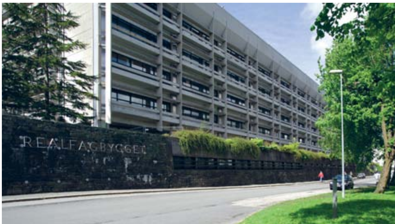
Realfagbygget, Universitetet i Bergen. Det sto ferdig i 1977, og med en bruksflate på 47 000 kvadratmeter er det en av de største enkeltstående bygningene i Norge.
