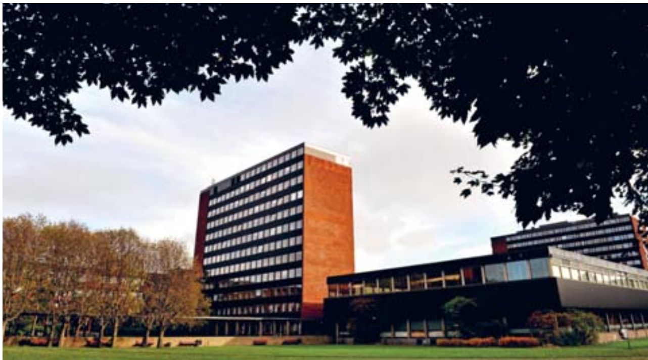
Sophus Bugges hus, Universitetet i Oslo, bygget i 1960.
