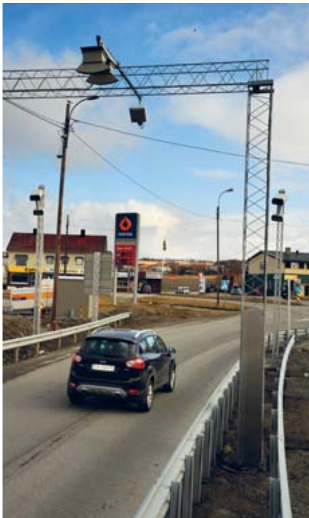
Kjelde: Knut Opeide, Statens vegvesen
