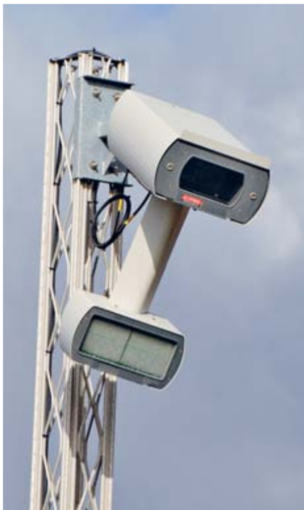
Kjelde: Knut Opeide, Statens vegvesen
