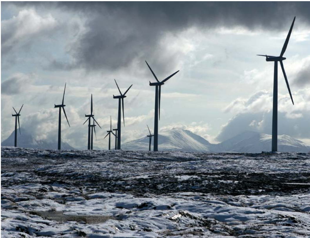
Smøla vindpark: Den første vindmølleparken i Norge ble bygget på Smøla i Møre og Romsdal, der første byggetrinn ble ferdig i 2002. Den består av 68 vindturbiner og produserer i gjennomsnitt 450 GWh årlig. Tiltakshaver vurderer å legge ned vindparken når konsesjonen går ut i 2025, eller når den tekniske levetiden til turbinene er utløpt. Årsaken er usikker lønnsomhet.
