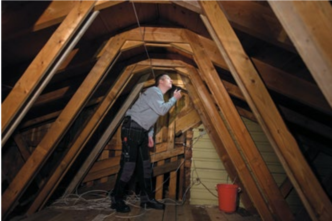
Lavenergiutvalget har som en hovedprioritering for perioden å jobbe med å heve kompetansen på energirehabilitering av bygg, med hovedvekt på boliger. Foto: © Torbjørn Tandberg / Lavenergiprogrammet
