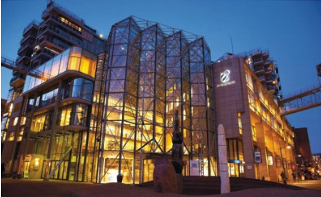
Det er ikke tradisjon i Norge for å etterprøve og evaluere energibruk i byggeprosjekter.
