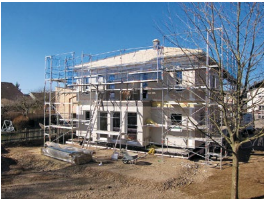
47 prosent av kommunene opplyser at de har gjennomført tilsyn på byggeplass.
