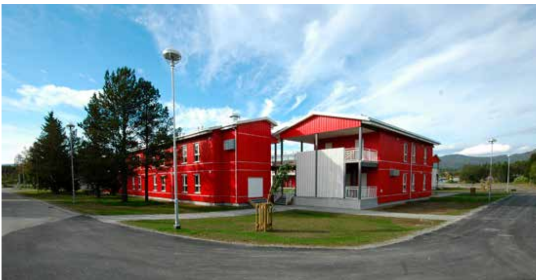
Befalsforlegning Setermoen, byggeår 2012. Eksempel på bygninger med god tilstand.
