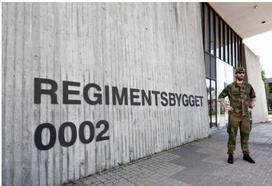
Regimentsbygg Rena, byggeår 1997. Eksempel på godt vedlikeholdt bygg, tilstandsgrad 1,03.
