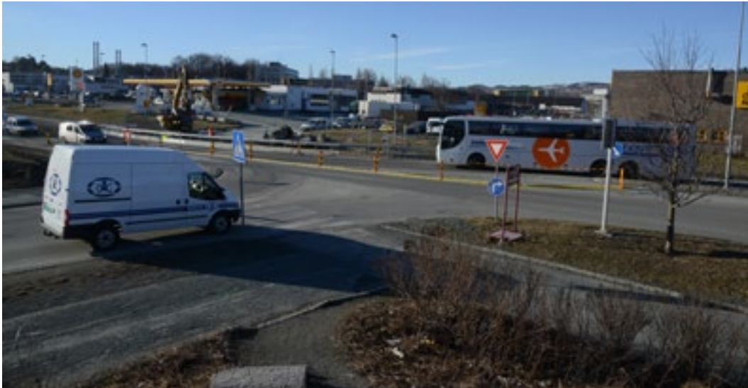
Trafikksikkerhet er en mye brukt begrunnelse for innsigelser fra Statens vegvesen. Foto: Knut Opeide, Statens vegvesen
