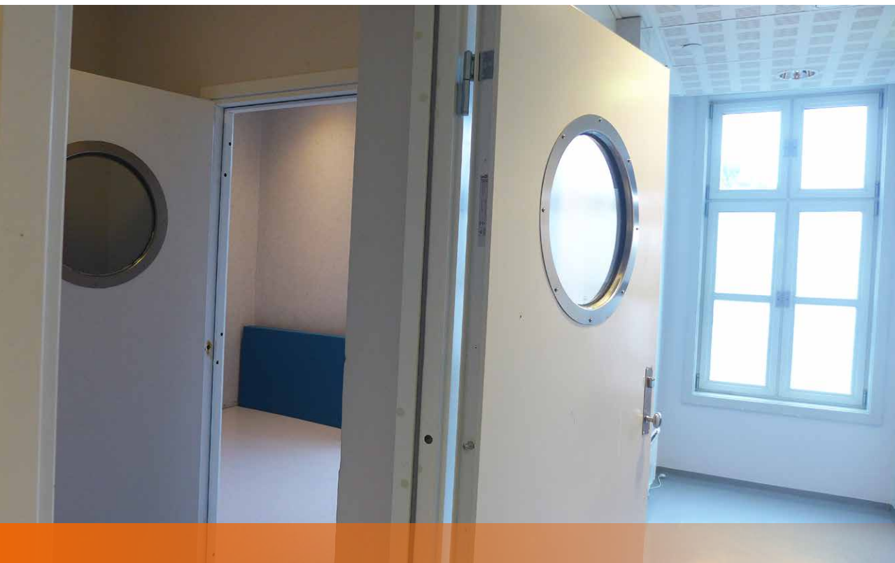
Skjermingsrom på et sykehus.
