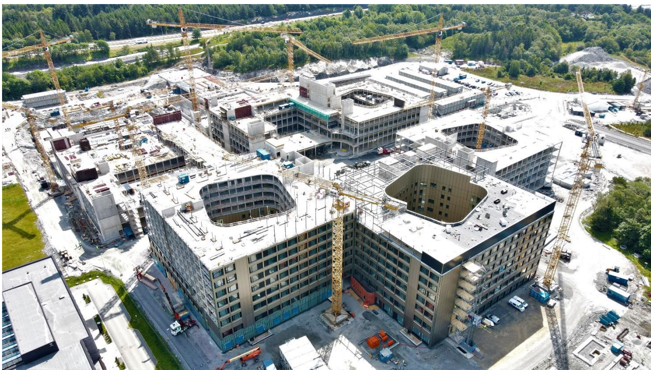
Bygging av nytt sykehus på Ullandhaug i Stavanger. Foto: Mikal Haga, Kruse Smith.
