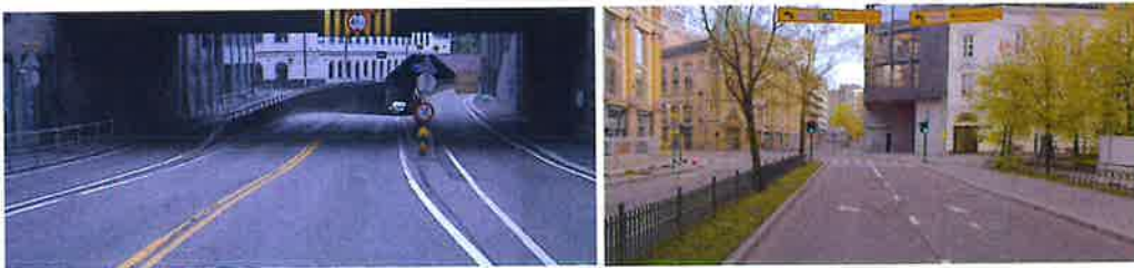
Figur 18: Et felt i hver retning i Vaterlandtunnelen (t.v.), og to felt i hver retning mellom tunnelen og krysset med St. Olavs gate (t.h). (Kilde: Vegbilder/Statens vegvesen mai 2021)
