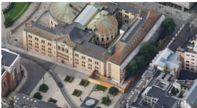
Figur 1: Flyfoto av stortingsbygningen og tilbygget. Foto: Gule sider.
